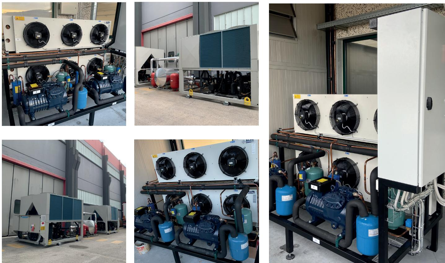
Impianti meccanici di condizionamento e distribuzione aria ad alta efficienza energetica, destinati a magazzini e sale di stoccaggio del materiale.
